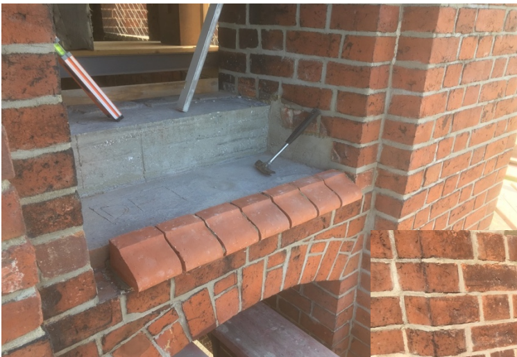
Bild 6 und 7: Wiederherstellung der Brüstung mit, dem Original nachgeformten, Klinkern
