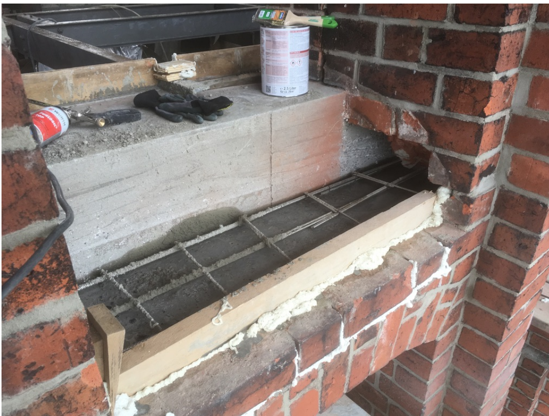
Bild 4: zweiter Stahlbetonträger (Korb horizontal gelegt wegen Brüstungshöhe)
