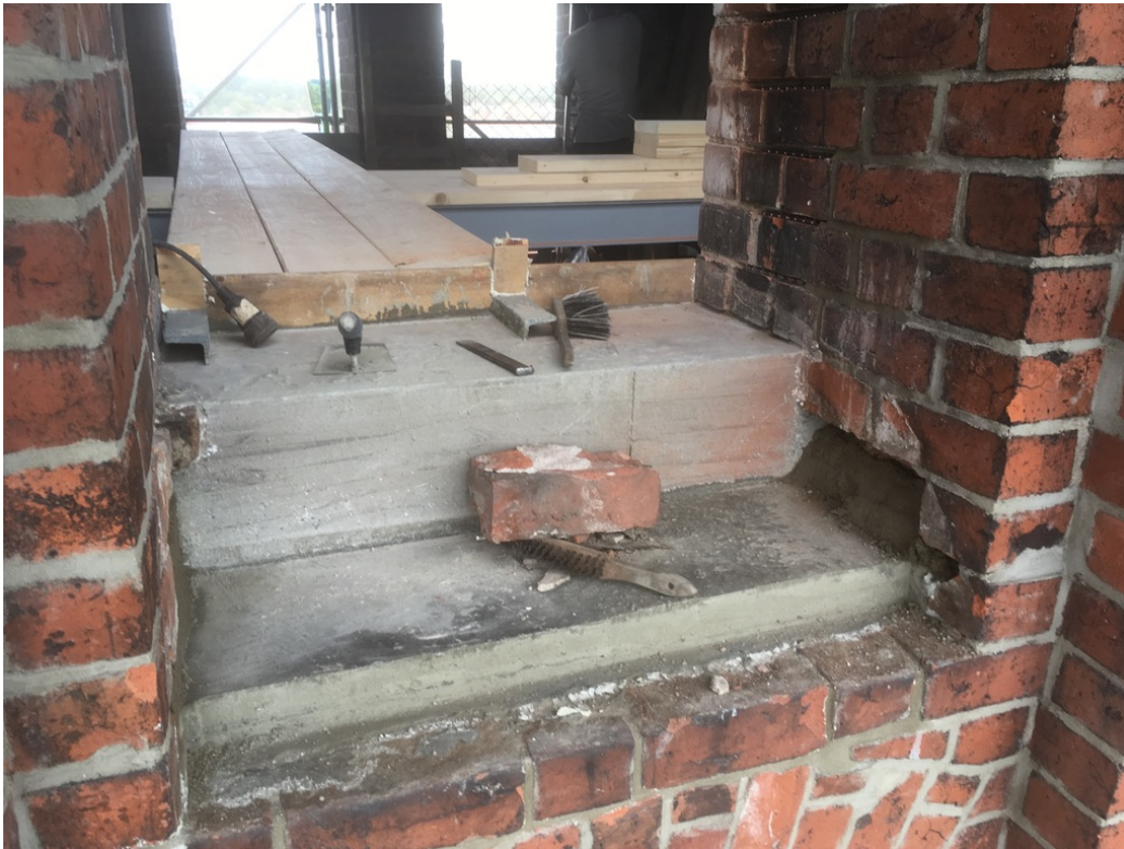
Bild 6 und 7: Wiederherstellung der Brüstung mit, dem Original nachgeformten, Klinkern
