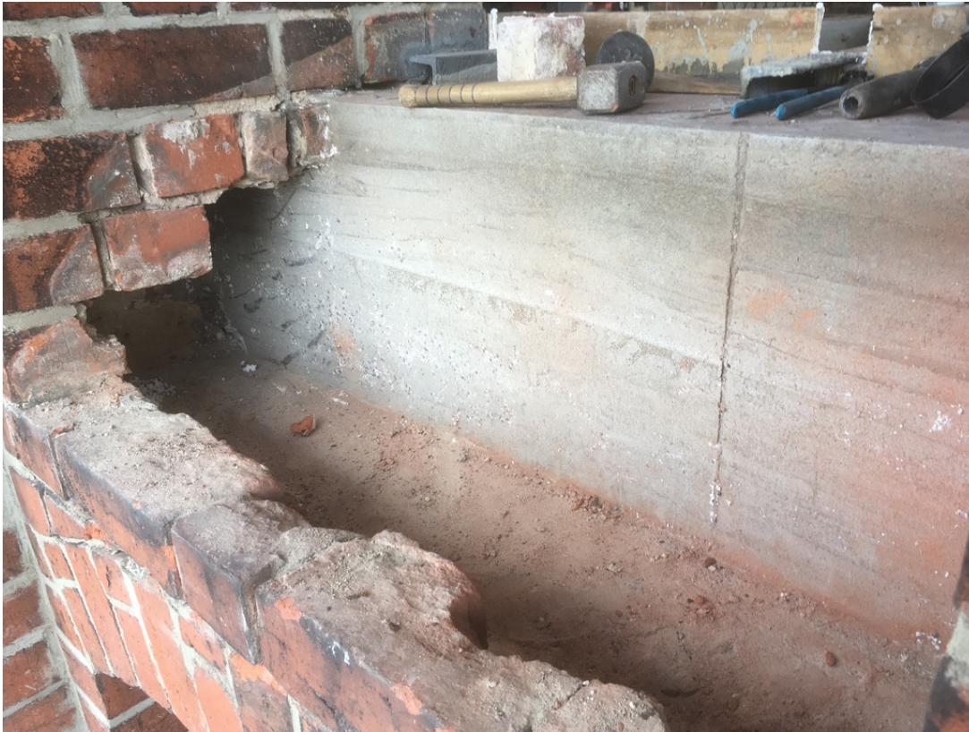
Bild 3: Stahlbetonträger I - bereits ausgeschalt. Verwendung von Gußbeton V80 C45
