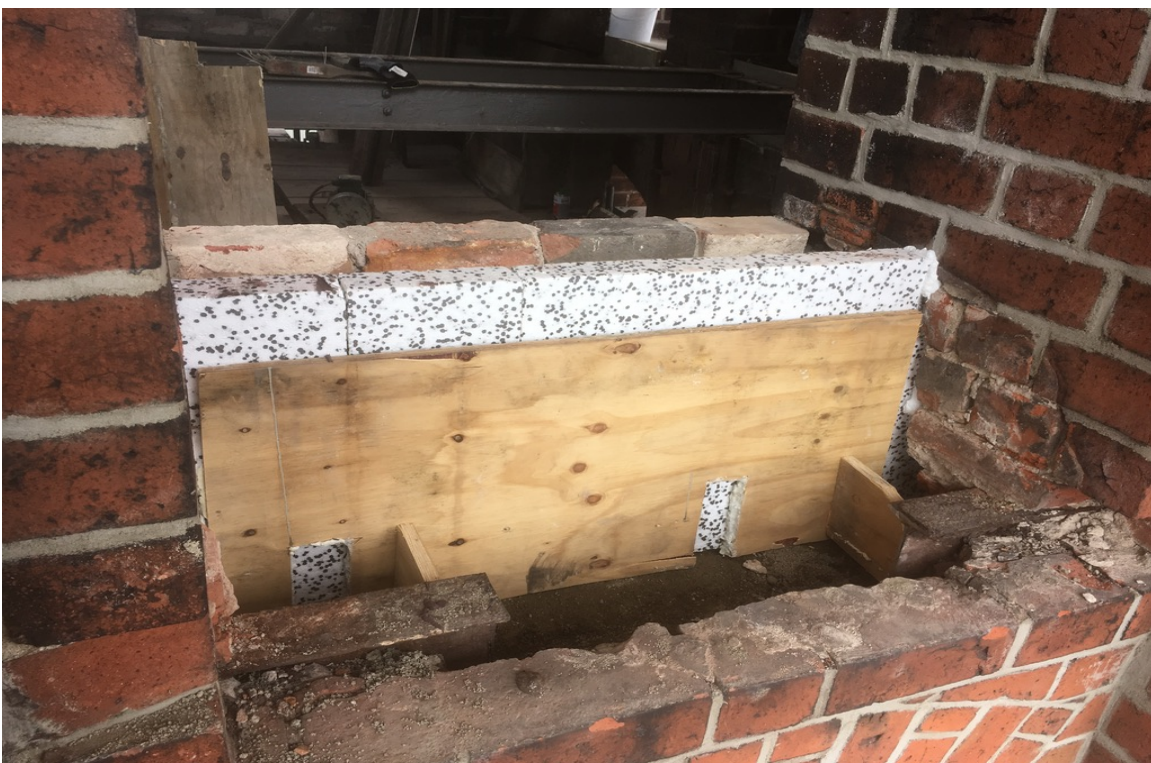
Bild 2: Vorbereitung/ Rückbau dritter Stahlträger
